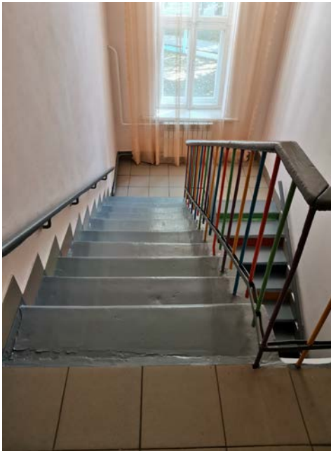
фото № 6 «лестница на 2-й этаж, 2-й лестничный марш»
