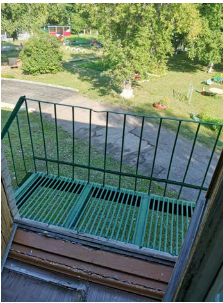
фото № 8 «Эвакуационный выход – 2 этаж»
