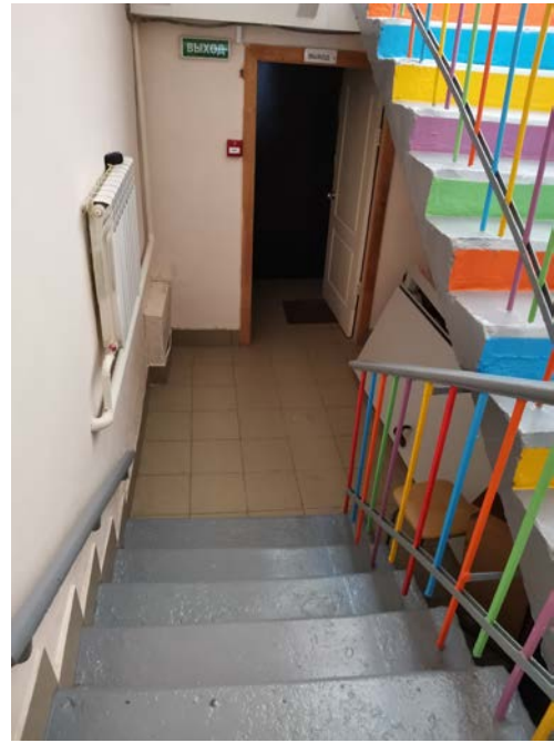
фото №5 «Лестница на 2-й этаж 1 лестничный марш»
