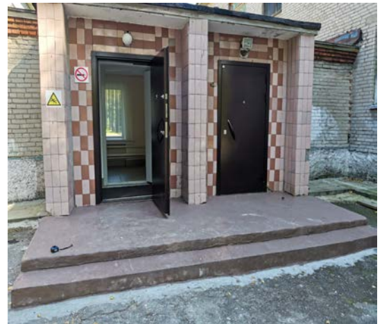
фото № 7 «Эвакуационный выход 1 этаж»
